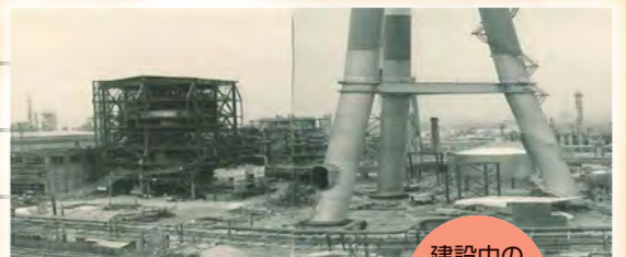
建設中のボイラー・集合煙突
