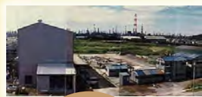
昭和60年透湿性フィルム工場周辺の様子
